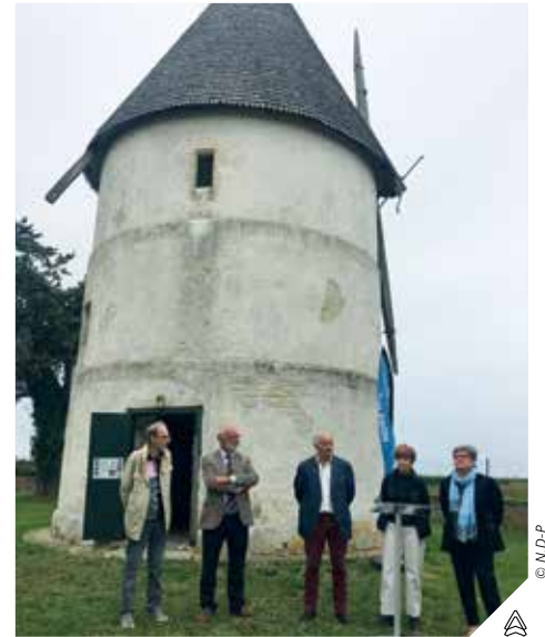
Le moulin de La Brée est l'un des derniers d'Oléron qui est surnommée l'île aux 100 moulins.
