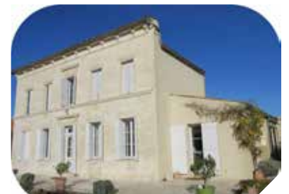
... et après nettoyage de la façade.
