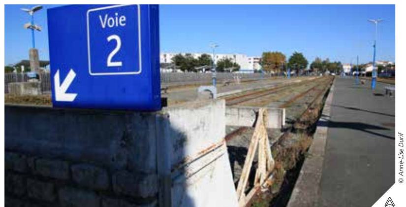
De la réfection de voies à l'aménagement de gares, la SNCF s'est engagée à effectuer les travaux demandés par la Région, avec 150 chantiers à venir, dont la ligne Royan-Angoulême.
