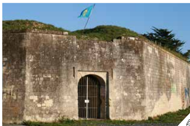
La Redoute, ouvrage dont les première tranche de travaux devrait être réalisée en 2024.
