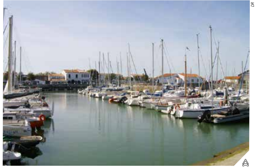
Le bassin de la Prée du port d'Ars devrait être protégé par un batardeau avant les grandes marées de mars 2024.
