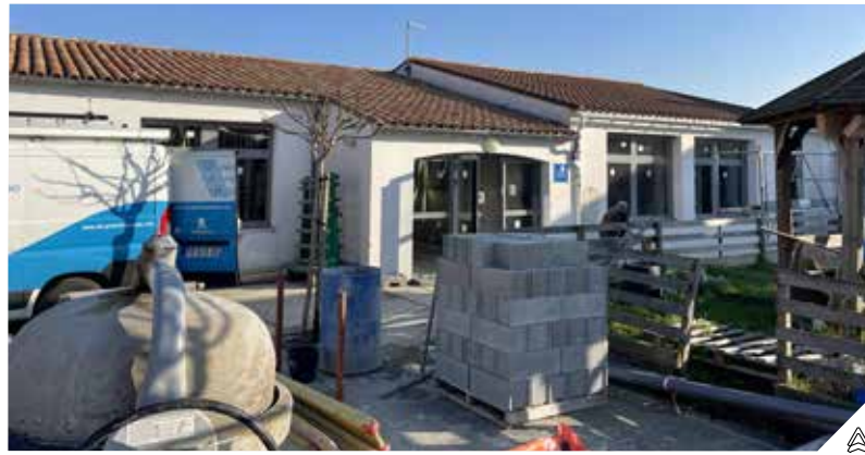
Les travaux de réaménagement de l'ALSH (centre de loisirs) ont débuté en novembre.
