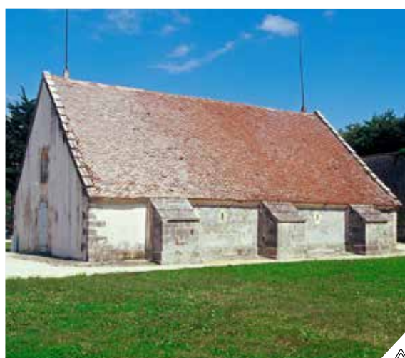
Débutés à l'automne 2023, les travaux de restauration de La Poudrière se poursuivent en 2024.
